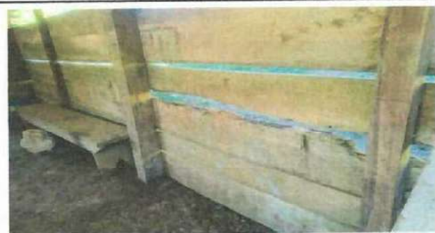
Foto 5: Fotografía de las paredes de la cocina necesitan ser rehabilitadas por block y malla
